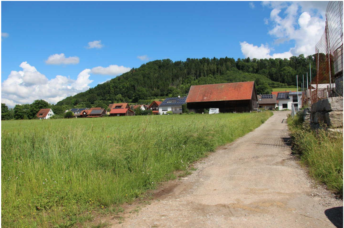
Foto 1: Blick von Südosten in das Plangebiet "Waagäcker – Erweiterung"; rechts bestehendes Gewerbegebiet
